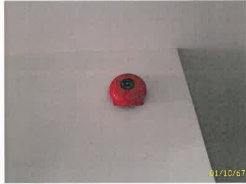
อุปกรณ์ส่งเสียงสัญญาณแบบกระดิ่ง ระบบตรวจสอบและแจ้งเหตุเพลิงไหม้ (ต่อ)
